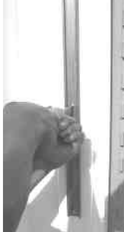
Din Rail Install
